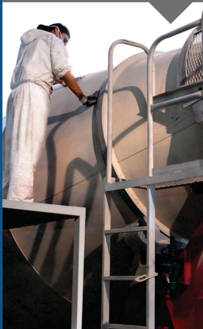
As Betoneiras são totalmente jateadas e pintadas em tinta poliuretana tipo fundo/acabamento com aplicação de duas demãos, conforme especificação do cliente.
